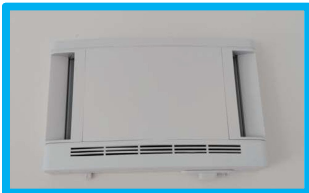
Vetracia štrbina Aereco z každej obytnej miestnosti do exteriéru
