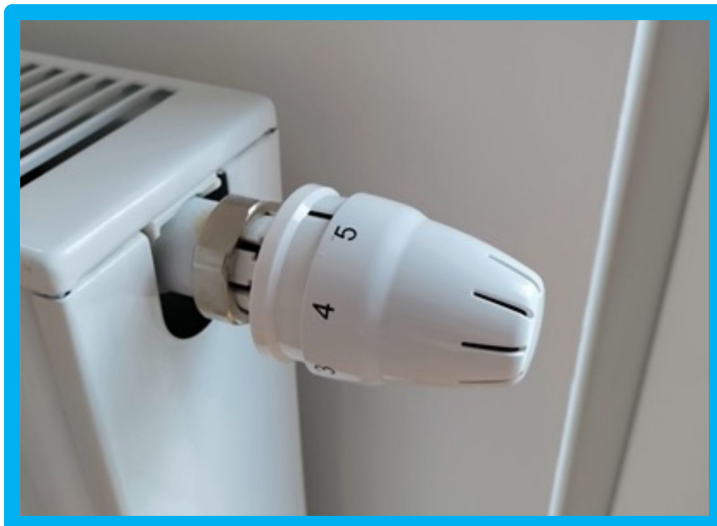
Radiátorová termostatická hlavica na reguláciu intenzity vykurovania v miestnosti
